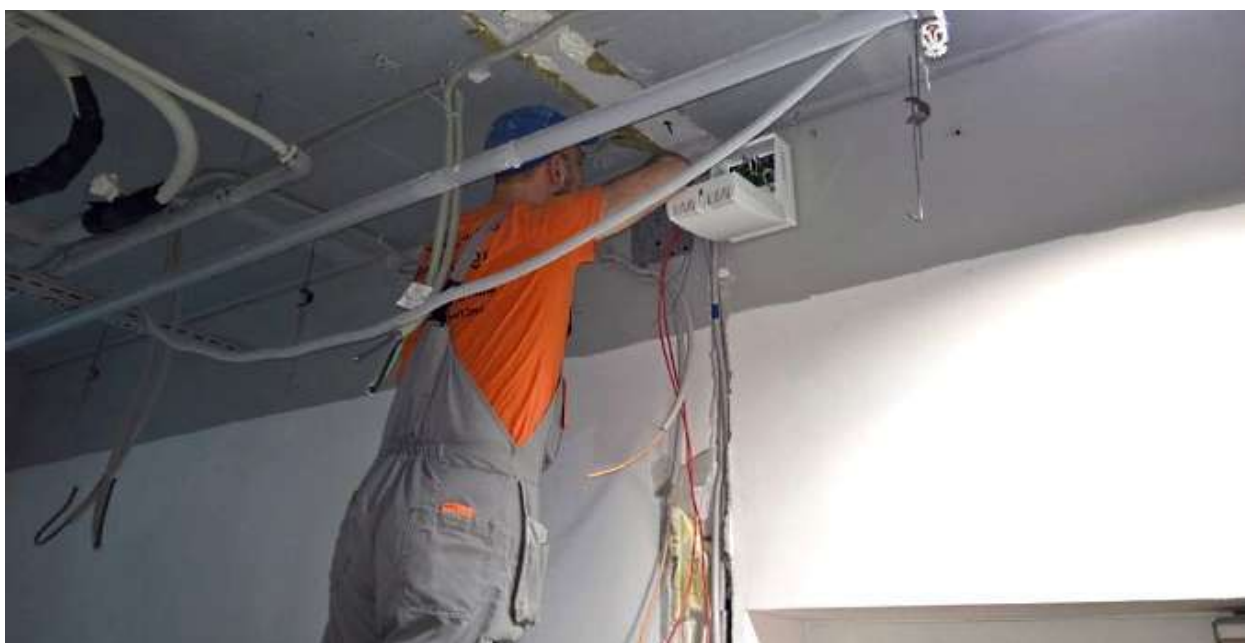
7-сурет-Кабельді монтаждау
