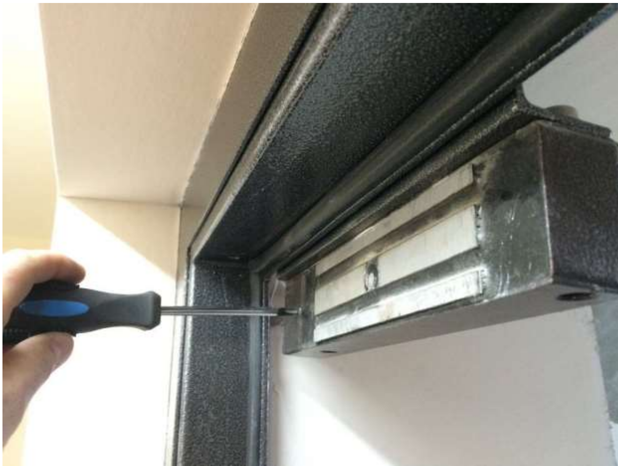
8-сурет-Электромагниттік құлыпты орнату
